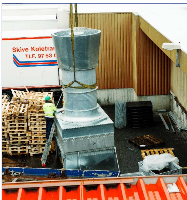
Figur 7: Ventilator monteret på hybridkøler
