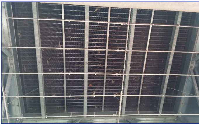
Figur 20: Køleflade og dysearrangement.
